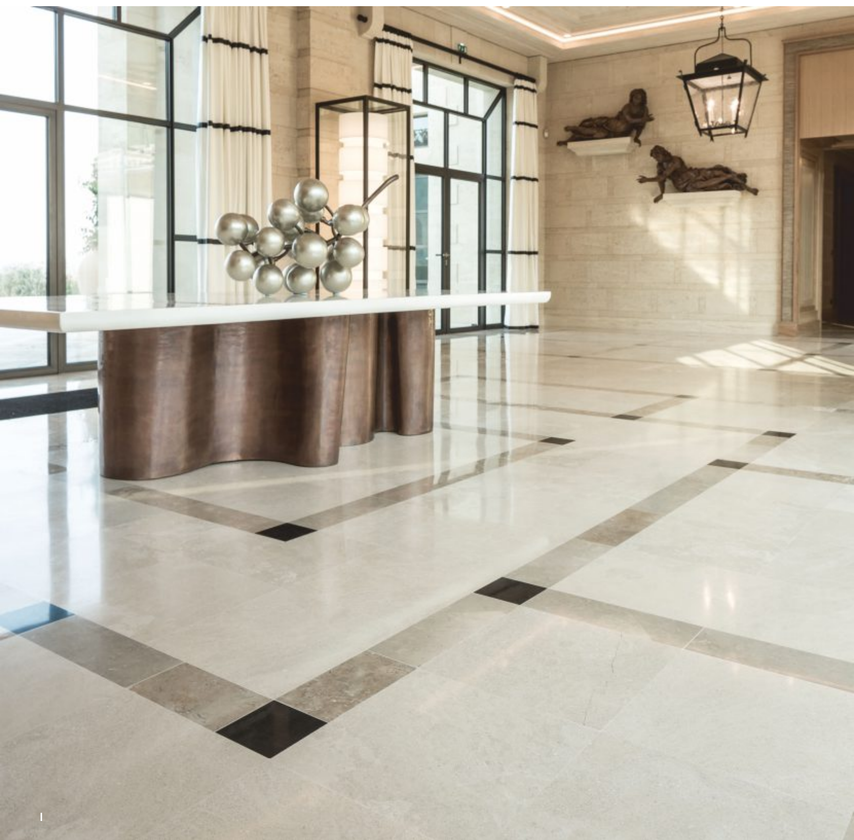
1. Accueil du Château - Carreaux Auberoche sable, bandes châtaigne, cabochons noir belge | 2. Salle de réception du château - Auberoche Saint-Emilion et bois | 3. Vue générale du château | 4. Lavabo en noir Zimbabwe | 5. Dallage de la salle d'accueil - Détail | 6. Escalier d'honneur du château - Auberoche Saint-Emilion et ardoise.
