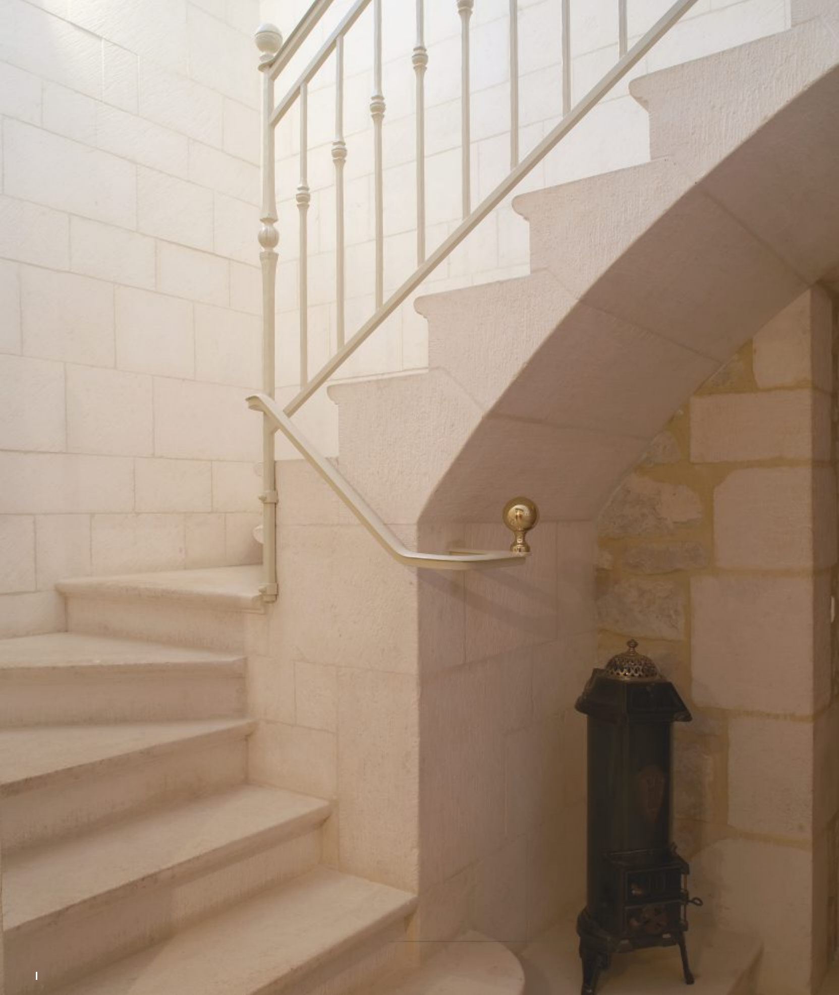
1. Escalier à clavage en Borrèze layée | 2. Détail sur cheminée style Louis XV en Auberoche claire | 3. Four à pain en Cénevières | 4. Piliers style XVII ème en Borrèze sablé | 5. Copie d'une porte Renaissance en pierre de Borrèze.
